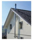
manque de chauffage puisque les gaz seront aspirés trop rapidement vers l'extérieur.
